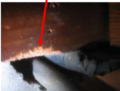
侵入口と成る電線の引き込み箇所
