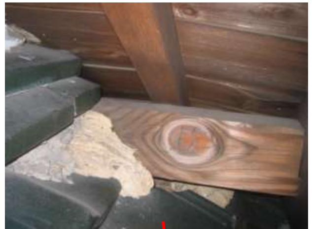
破風の付け根は大きく 穴が開いたまま
