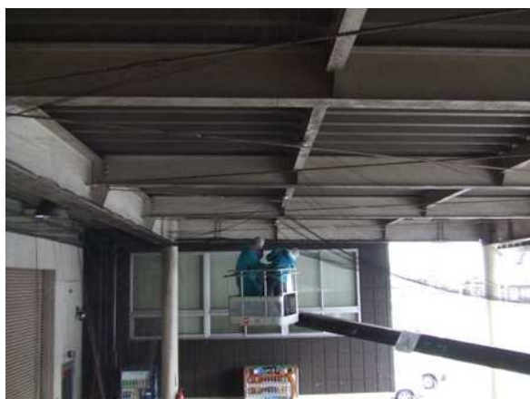
工場の鋼材部分へ飛来営巣防止にネット張り中
