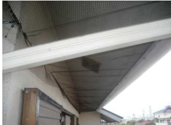
鼻隠しから壁面に垂直に成る様に張る
