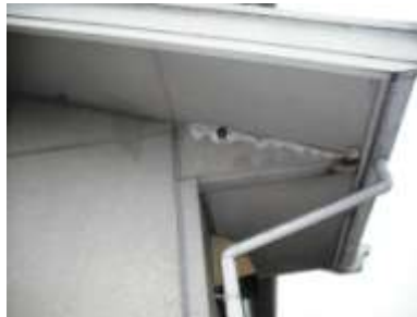
1階東面の北側 軒天井付近
