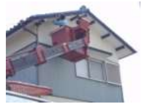
高所作業車を利用して
