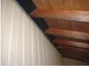
トタンと垂木の隙間補修
