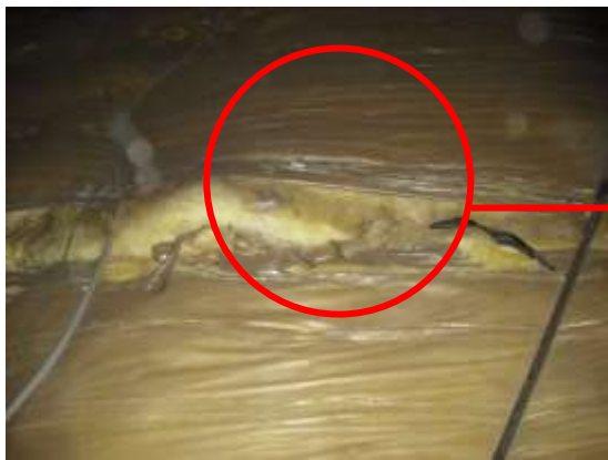
2階ユニットバスから西へ2m程の位置 断熱材をめくると天井材に糞の堆積が見られる
