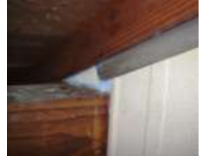
もや部分の補修
