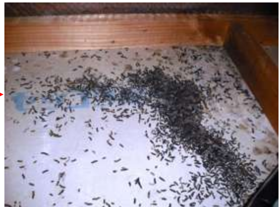
2階ユニットバスから西へ2m程の位置 断熱材をめくると天井材に糞の堆積が見られる
