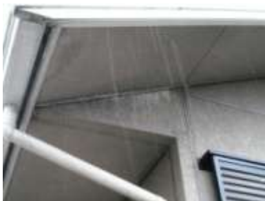
2階東面の南側 軒天井付近
