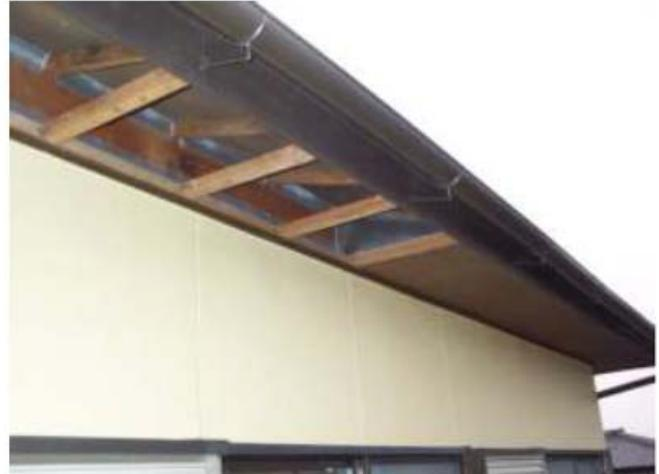
軒天井内に堆積した糞を清掃する為に一部を剥がして清掃をします。
