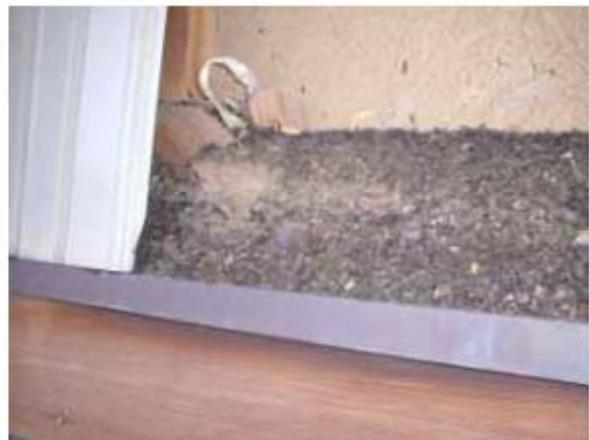
足場を組み立て、外壁トタンを剥がしながら壁面内部に堆積した糞を清掃します。
