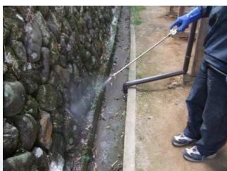
水溶性薬剤による処理風景
