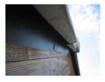
破風板と瓦の隙間部分へケラバ板金を取り付け、隙間を更にコーキングでふさぎます。
