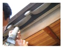
瓦の下の漆喰部分は経過年数と共に離脱します、スズメ込み板金を取り付けコーキングで補修
