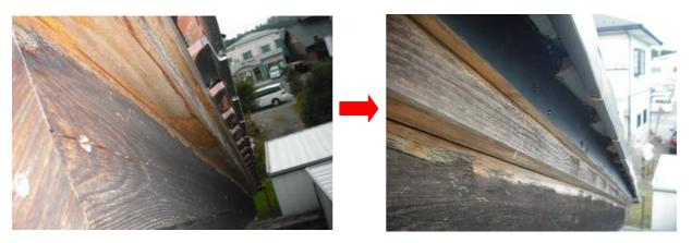
破風板の上部と瓦の隙間へ鳥類やコウモリの侵入を防ぐ、ケラバ板金の取り付け
