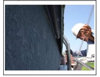
11 補修:侵入箇所及び隙間の補修 補修材料をシリコンコーキングで更に固定
