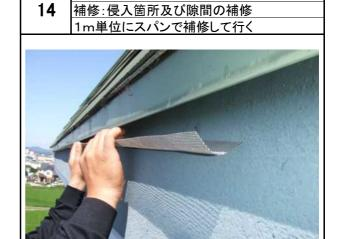
15 補修:侵入箇所及び隙間の補修 ネットの弾力性を利用して固定
