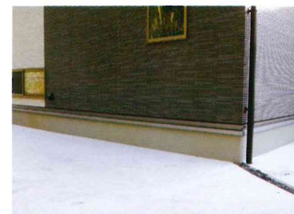
基礎パッキング住宅に取り付け
