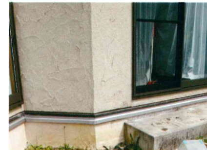
洋風住宅 基礎に取り付け
